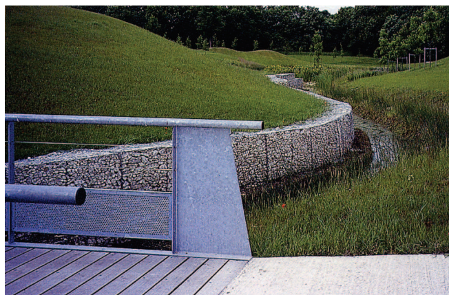
Le gabion ou l'enrochement calepiné pour un gain de volume de rétention
