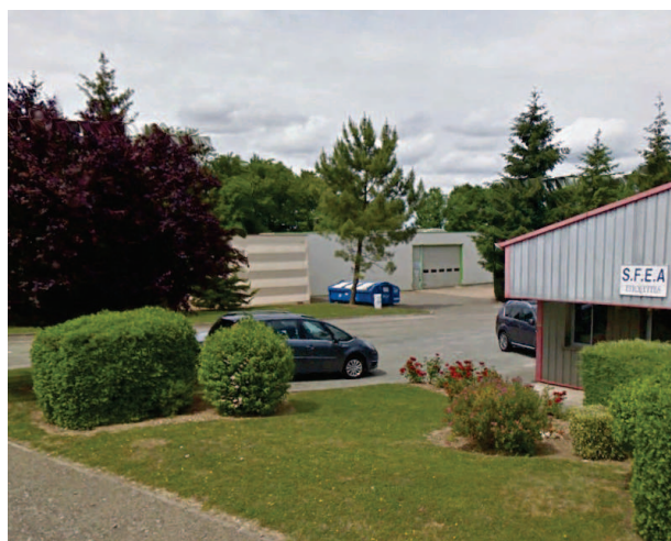
Lot sans clôture, entrée bien entretenue et façade en bois
