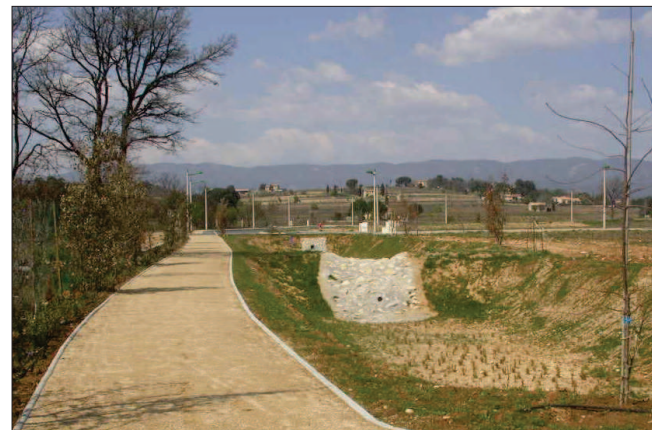
Voie d'entretien et bassin de rétention
