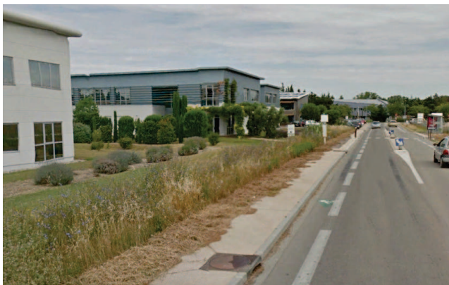
Respecter un alignement des façades pour la qualité du paysage, la valorisation des entreprises et l'attractivité du patrimoine de la zone d'activités. (Avignon)
