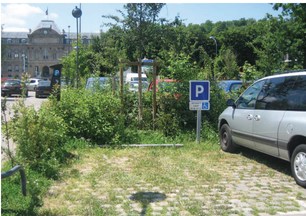
Stationnement de véhicules au sol perméable
